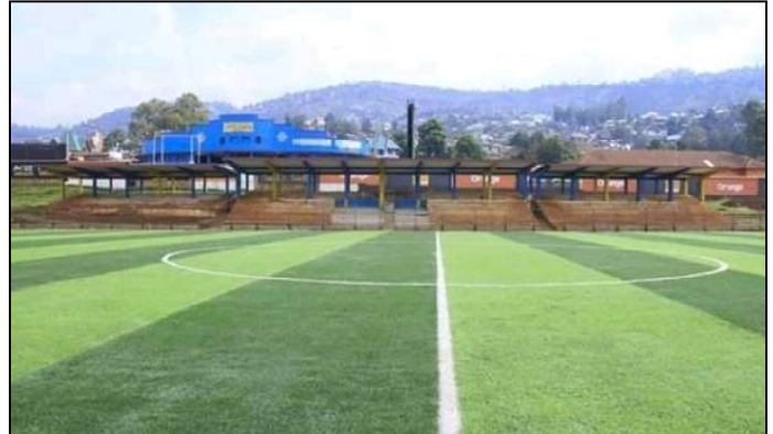
L'aire de jeu du stade de la Concorde dans la commune de Kadutu à Bukavu a été réhabilité et inauguré le 2 août 2019. Photo Droits Tiers
